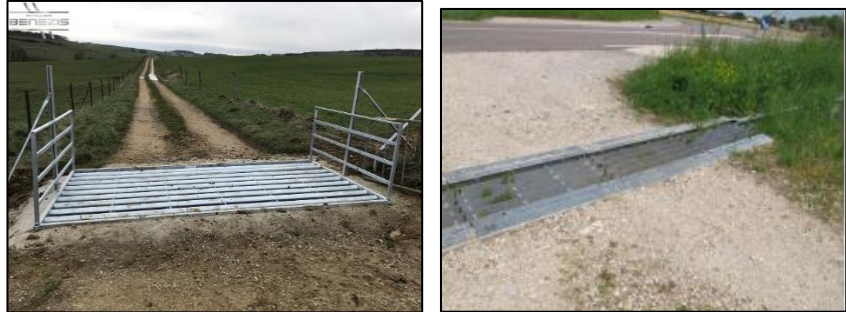
Figure 23 : Exemple de passages canadiens (Source : Metallerie Benezis et CEREMA)
